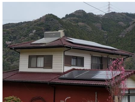
太陽光発電も太陽熱温水器もある家
